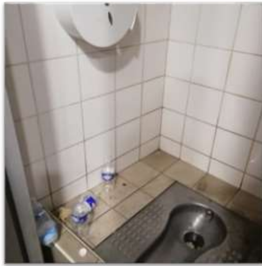
Toilette à l'intérieur du local
